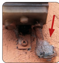
Protecção da entrada do tubo corrugado
