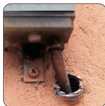
Protecção da entrada do tubo corrugado
