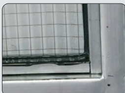
Selagem de vidros
