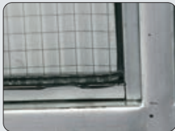
Selagem de vidros
