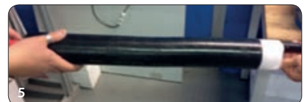
5 De externe beschermhuls wordt aangebracht en gemonteerd
