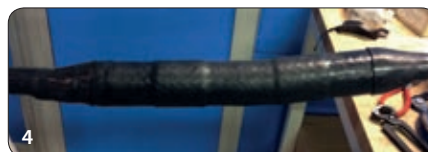
De aansluiting is gereed en kan onmiddellijk worden gebruikt
