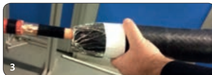
Aangebracht in het midden van de aansluiting
