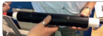
2 Aangebracht in het midden van de aansluiting
