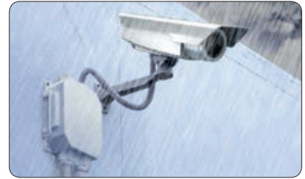
Installatie met vrije kabels.
