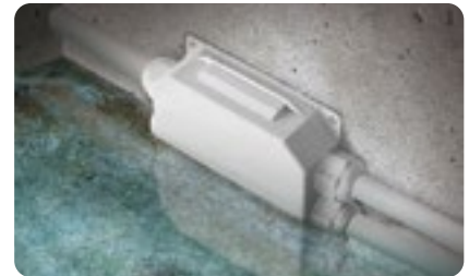
Installatie met kabelleidingen.
