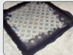
Afdichten in bouwruimtes
