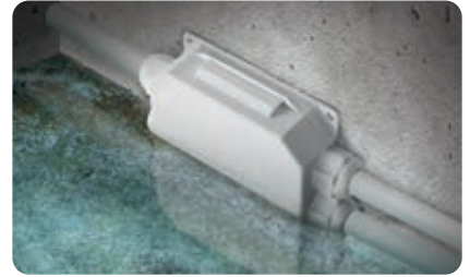
Installatie met kabelleidingen.
