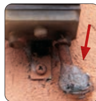
Bescherming ingang geribbelde leiding ...
