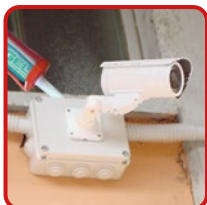
Impianti di videosorveglianza
