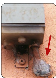
Protezione ingresso tubo corrugato
