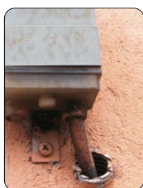
Protezione ingresso tubo corrugato
