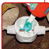
Connessioni interrate
