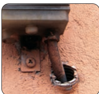
Protezione ingresso tubo corrugato
