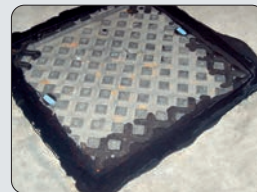
Sigillatura pozzetti
