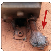
Protezione ingresso tubo corrugato
