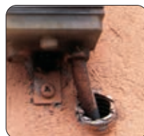
Protezione ingresso tubo corrugato
