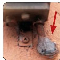
Protezione ingresso tubo corrugato
