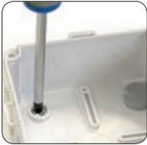
La boîte est fixée à la paroi et les vis sont couvertes à l'aide des bouchons.
