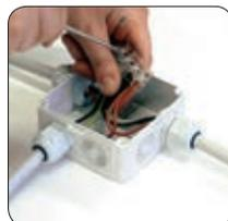
Desfilas los cables y realizar la conexión.
