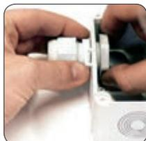
Instalar los sujeta cables.
