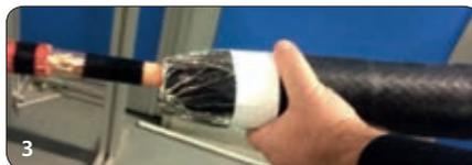
La junta está encastrada en el cable conectado
