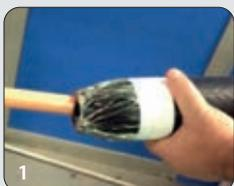
1 El cuerpo de la junta lleva integrado el blindaje y la funda externa.
