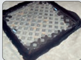
Sealado de pozos
