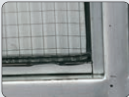
Sealado de vidrios
