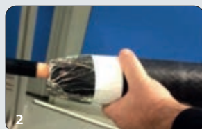
2 Colocada en el centro de la conexión.
