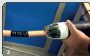
3 La junta está encastrada en el cable conectado.
