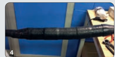
4 La junta está lista y puede ponerse inmediatamente en funcionamiento.
