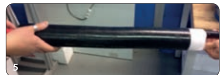
5 Die äußere Schutzhülle positionieren und installieren
