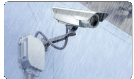
Installation mit Kabeln.
