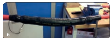
6 Die Verbindung ist bereit und kann sofort unter Spannung gesetzt werden
