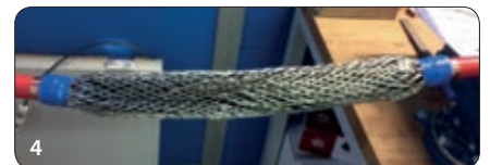
4 Metallabschirmung wieder herstellen
