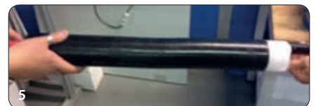
5 Die äußere Schutzhülle positionieren und installieren
