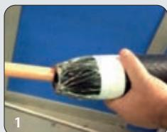
1 Der Verbindungskörper trägt den eingebauten Schirm und die Außenhülle
