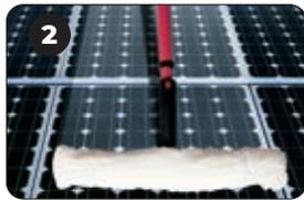
2 Je nach Verschmutzungsgrad einige Minuten einwirken lassen. Mit einem weichen Tupfer oder einem weichen, nicht-scheuernden Schwamm (angefeuchtet) einreiben.
