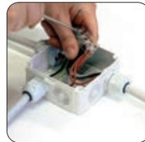
Kabel einführen und anschließen.
