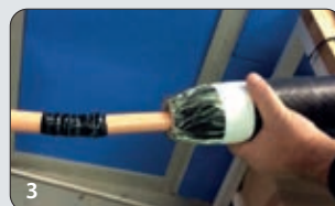
3 Der Körper wird in der Verbindungsmittle positioniert
