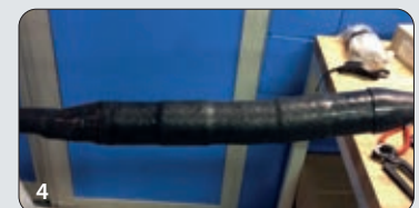
4 Die Verbindung ist fertig und kann sofort unter Spannung gesetzt werden
