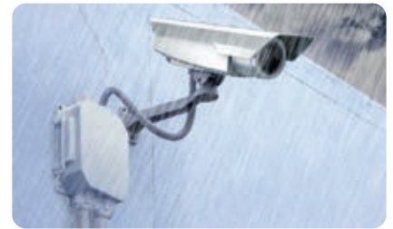
Installation mit Kabeln.
