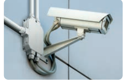
En la pared con cables
