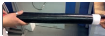
5 Se coloca en posición y se instala la funda externa de protección
