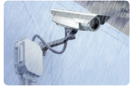
Instalación con cables libres
